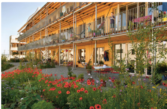
Nachhaltig bauen konkret: Wohnüberbauung Oberfeld, Ostermündigen
