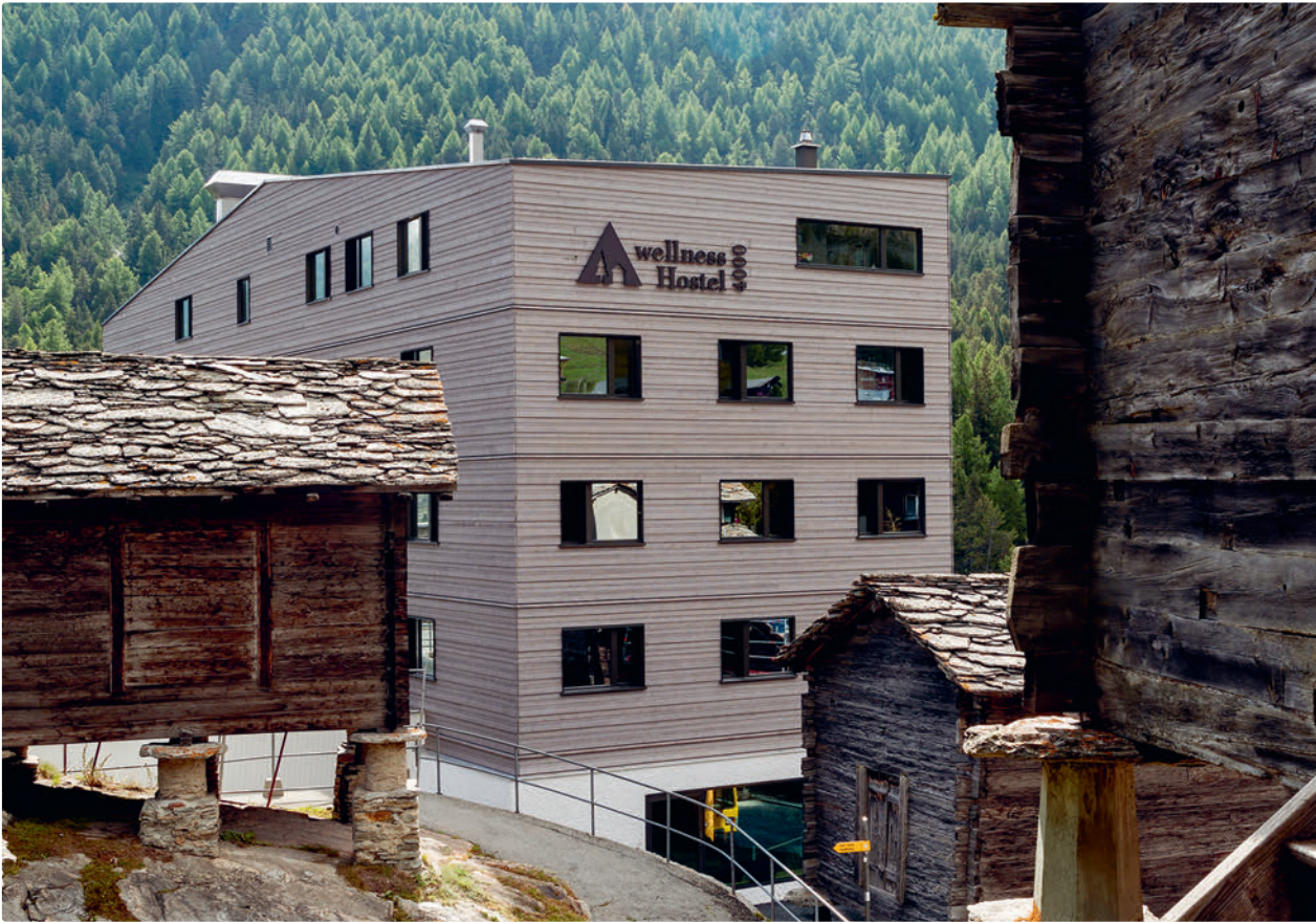
Die aktuellen Brandschutzvorschriften VKF favorisieren den mehrgeschossigen Holzbau – im Bild die Schweizer Jugendherberge in Saas-Fee.
