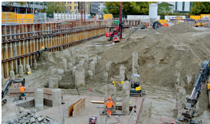
Die Vielfalt der Geotechnik im Bild: Baugrubenabschlüsse, Verankerungen, Pfahlfundationen.
