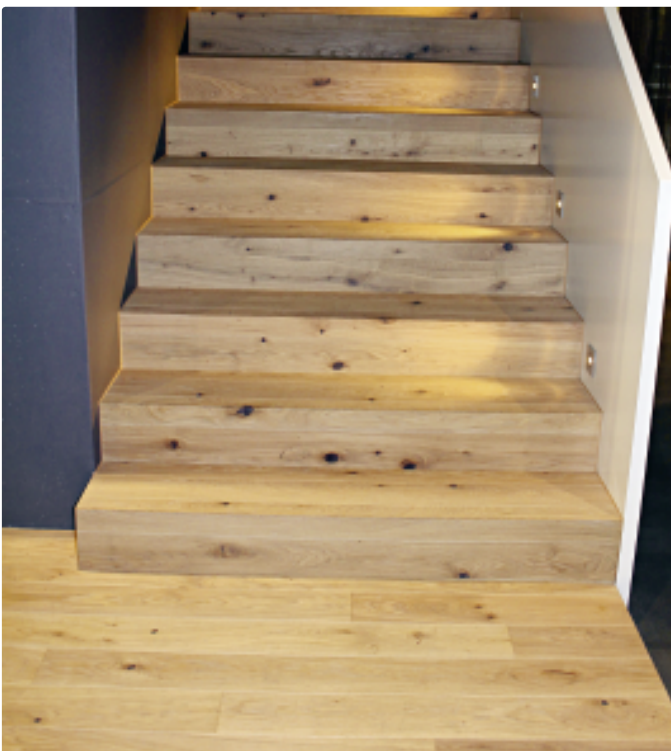
Revêtement d'escalier en béton
